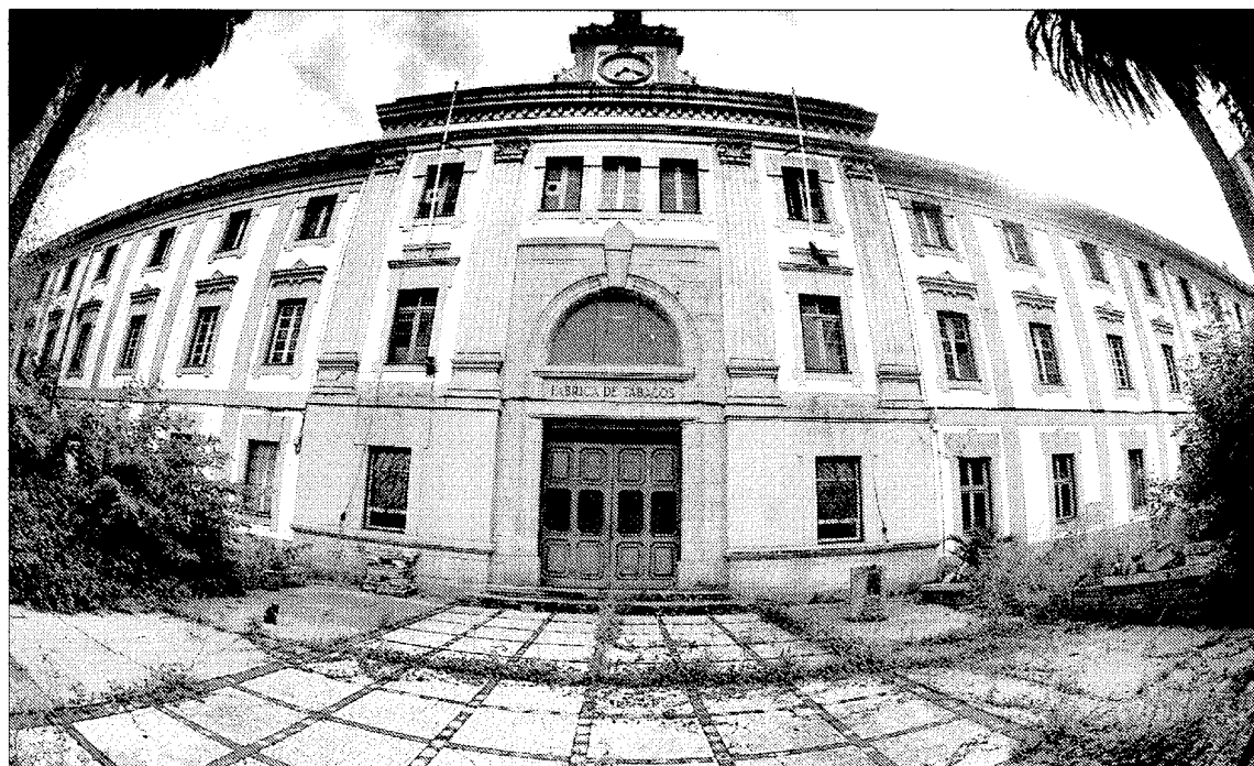
Fachada de la Fábrica de Tabacos, en la plaza de A Palloza. / FRAN MARTINEZ
